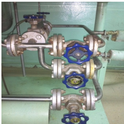
5 дугаар зураг. НТНТ-10А төхөөрөмжийн хүйтэн ус болон уур оруулах хавхлага
