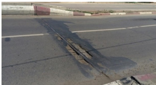
7-р зураг. 2015 онд гүүрний хэв гажилтын заадсанд гарсан эвдрэл, гэмтлийн харагдах байдал
