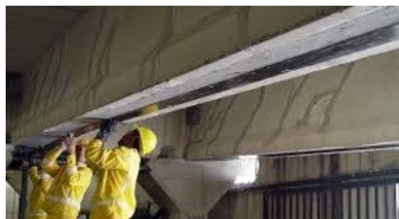
25-р зураг. Нүүрстөрөгчийн утсаар нэхсэн даавуу (sica wpar), хатуу пластик туузан наалт (carbodur) ба эдгээрийг наах полимер цавуу carbodur 30 ба 31CF.
