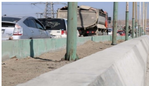
5-р зураг. 2010 оны “Гурвалжингийн гүүр”-ний их засварын дараах харагдах байдал. Хос гүүрний дунд хэсэгт шороон дүүргэлттэй байсан.
