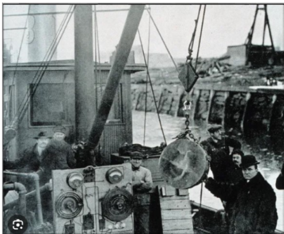
1-р зураг. Анхны цуурай дуугаргах Fessenden Fathometer төхөөрөмжийг усан онгоц дээр 1924 онд суурилуулсан
