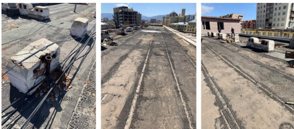
Зураг 8.9. Оюутны байрны дээврийн засвар
